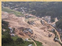
九州北部豪雨 2017年7月 Northern Kyushu heavy rain July 2017
