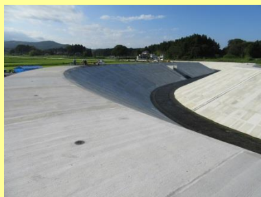
沖ノ田川防潮堤
